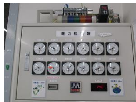
自作のデマンドコントロール
