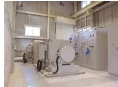
小水力発電設備
