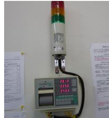
デマンドコントロール
