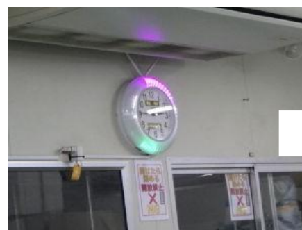
「デマンドコントロール」
