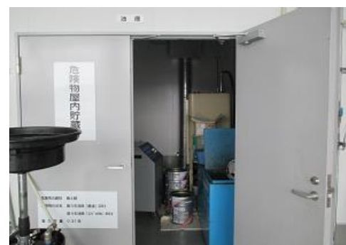
少量危険物倉庫
