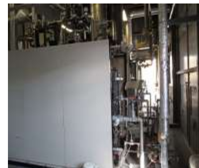
天然ガスボイラー
