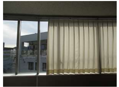
遮熱・防煙カーテン
