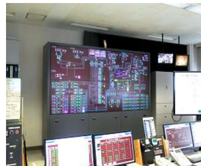
中央コントロール室
