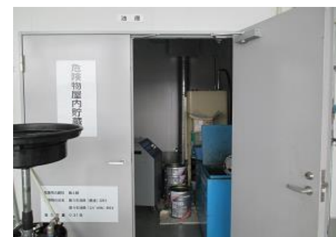
少量危険物倉庫
