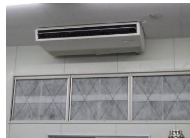
フィルタ設置
