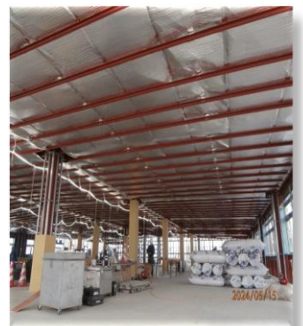
【データセンターでの施工】
