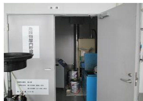
少量危険物倉庫
