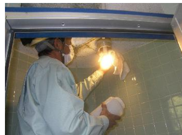
公園トイレの電球清掃・点検
