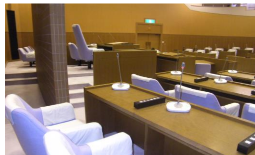
会議場の中継システム工事
