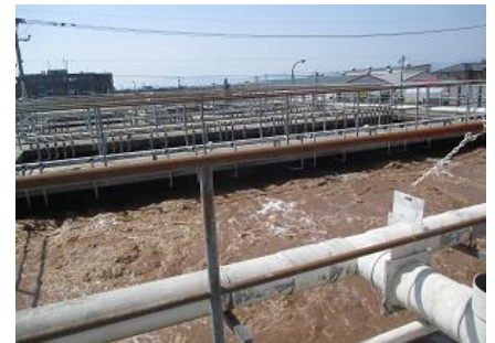
排水処理施設
