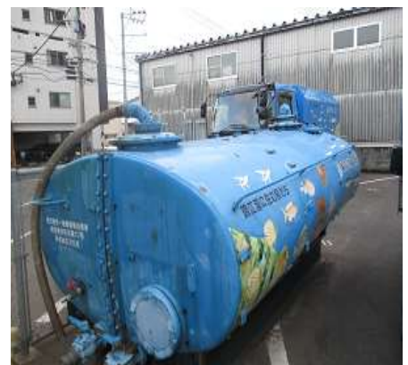
雨水貯留タンク
