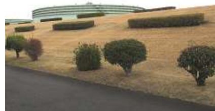
原油備蓄タンク
