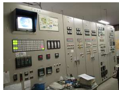
発電管理システム
