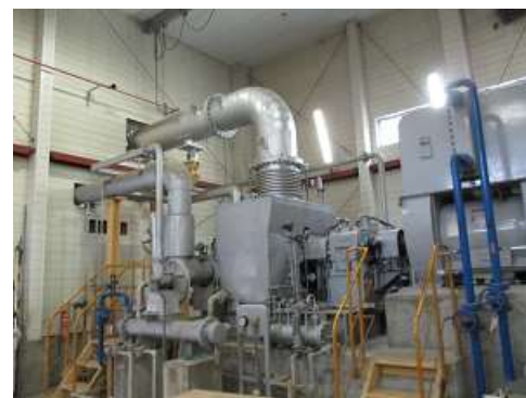
バイオマス発電機
