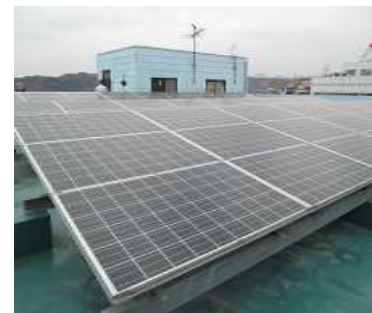
屋上のソーラーパネル
