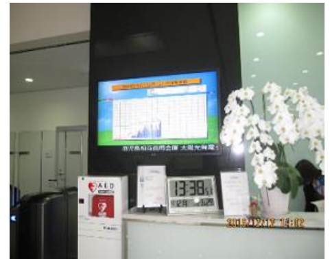
ソーラー発電管理システム
