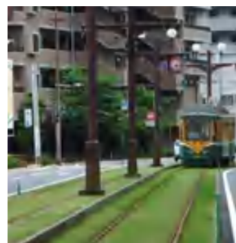
市電軌道敷の緑化
