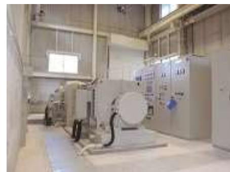
小水力発電設備
